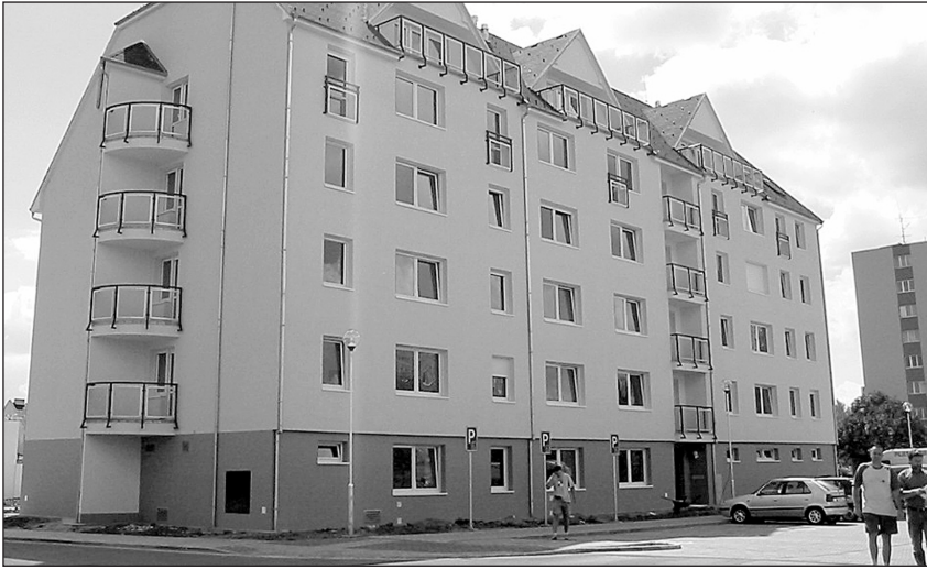
Nový bytový dům s 50 bytovými jednotkami v ulici E. Králíka.
