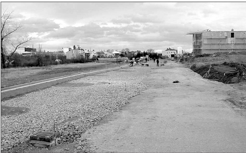
Inženýrské sítě a komunikace v lokalitě Za Nerudovou ulicí.
